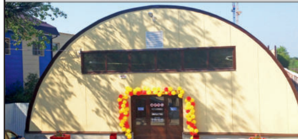
СКЛАДСКИЕ И ПРОИЗВОДСТВЕННЫЕ ПОМЕЩЕНИЯ
